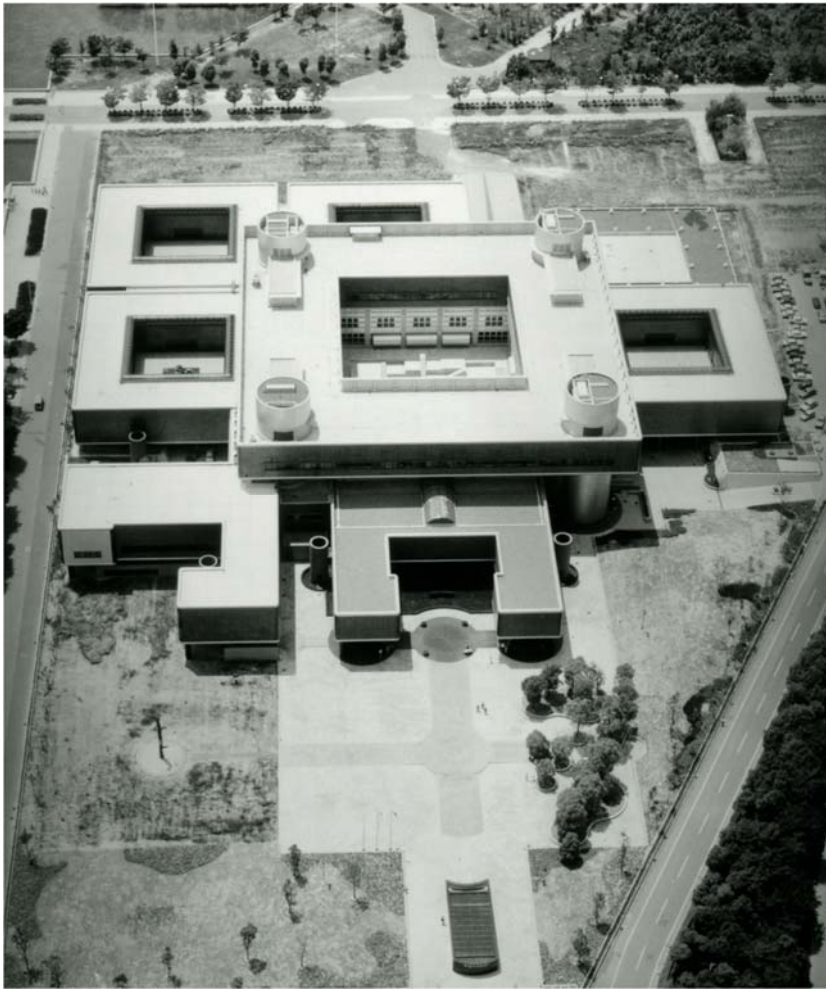
建設当初の航空写真
