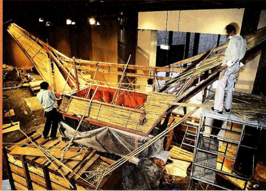
東南アジア展示 トラジャの穀倉の 屋根葺き替え作業 (1996年)
