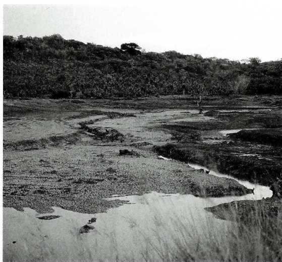
濁水被害で干上がったヤップ島内のダム(1983年5月)
