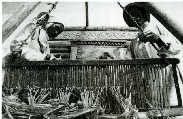
(写真2)西シベリアのタタル人のゴザ織りに使われている開孔板綜統(ロシア民族学博物館)
