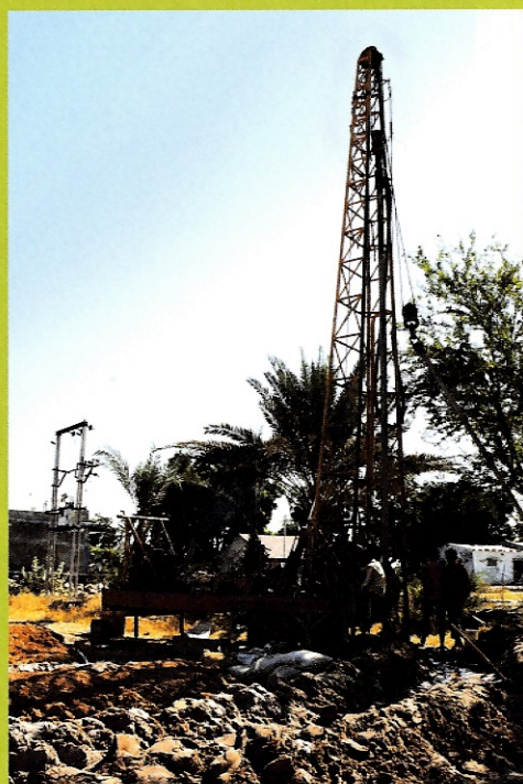
井戸を掘削する。2007年11月、ダマルカー村
