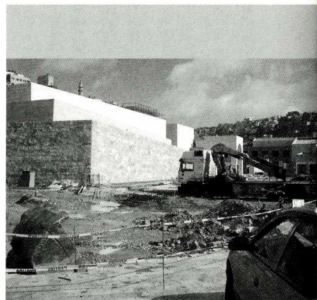
2007年12月時点で建設中の国立ヨルダン博物館。外装は石で化粧張りするのが公共建造物の常である
