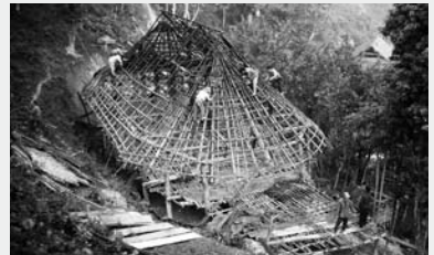
「亀の甲」型家屋の解体
