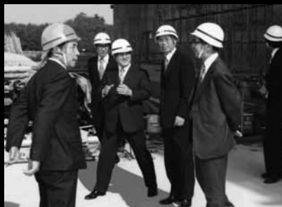
定礎式後、建設現場を確認する
