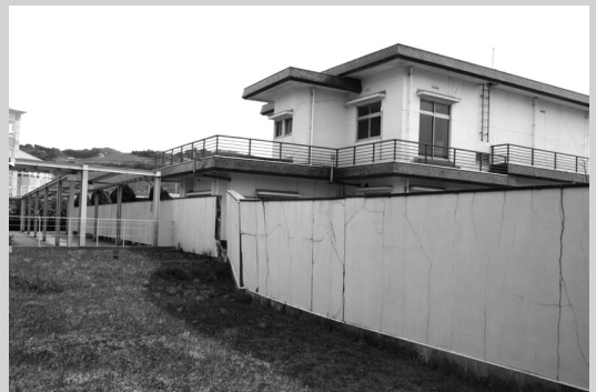
断層の脇にあった民家も保存されている
