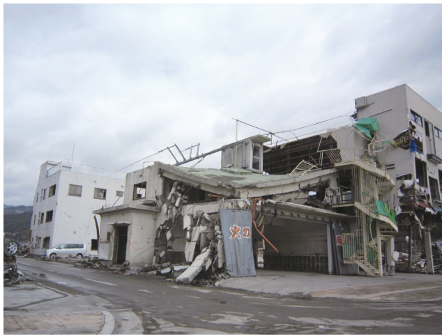
全壊した大槌消防署。大槌町では消防署員のほか、多くの消防団員が亡くなった。
