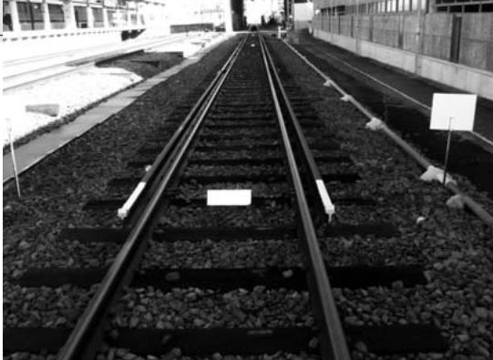
大阪北部私鉄と南部私鉄の接点といえる近鉄橿原神宮前(かしはらじんぐうまえ)駅構内にある四線区間。内側二線が南大阪線・吉野線の狭軌、外側二線が橿原線の標準軌
