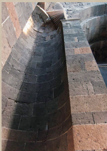
水平に連続する切石の目地
