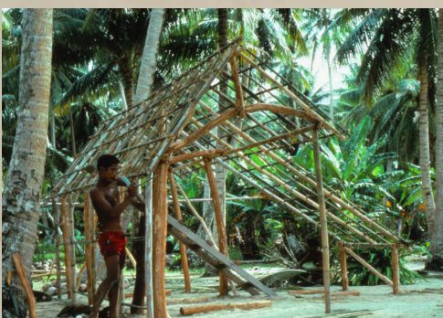
カヌー小屋の仮組作業 (ミクロネシア、ヤップ島。1981年)
