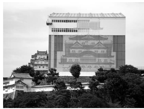
大天守閣保存修理中の姫路城。城の線画が描かれた素屋根に覆われている。1993年世界遺産に登録（2013年6月撮影）
