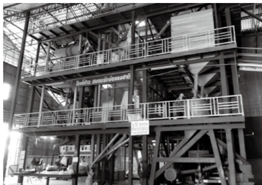
国などの資金援助で巨大な精米施設を建設する組合もあらわれた
