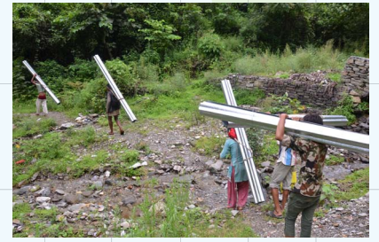
丸めた波形鋼材をひとり2枚運ぶ。雨季に入り仮設住居の補修が急ピッチ
