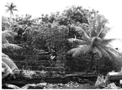
井桁状に柱状玄武岩を八メートルにも積み上げた酋長墓の周壁（撮影・関根久雄）
