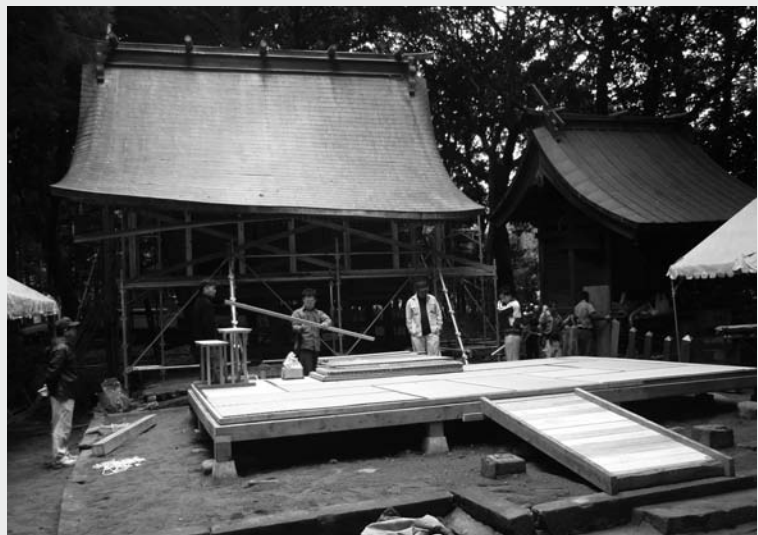
神楽の舞台は地震で崩れた拝殿跡に設置されたもの。ボランティアによって作業が進められた
