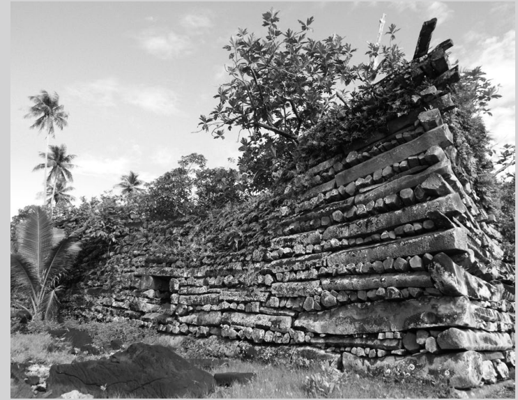
首長が眠るナンマトル遺跡の人工島、ナントフス島の柱状玄武岩の外周壁(2014年)
