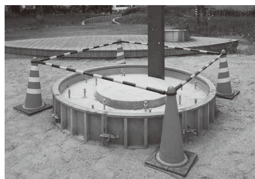
トーテムポール立ち上げ前のようす。鉄製の支柱の基に立つ予定です
