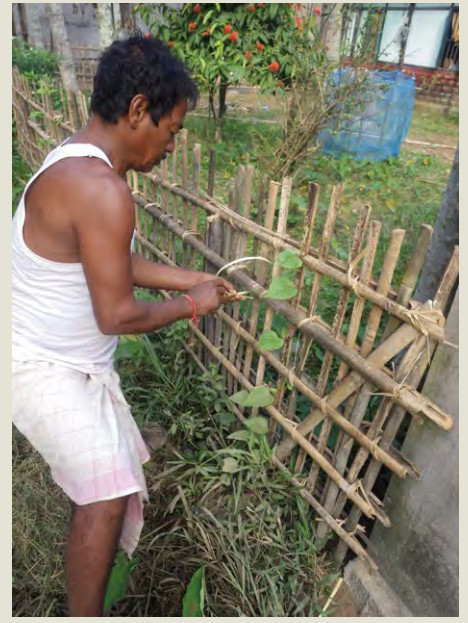
上:雨季明けには大量のタケヒモを準備する 下:雨によって壊れたフェンスをつくり直す
