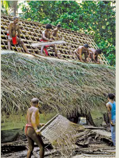
ココヤシの屋根葺き材を投げ上げて屋根葺きをする(ングルー環礁、1980年)
