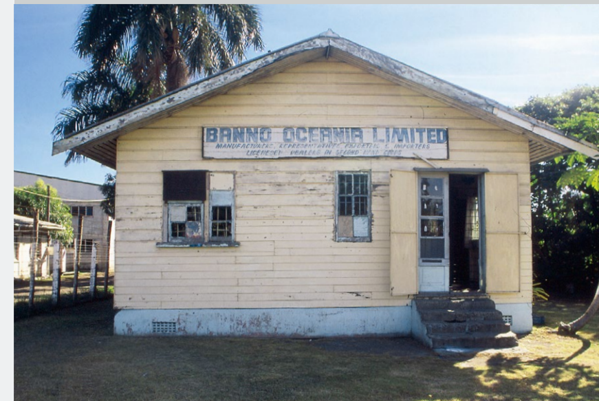
ラウトカのバンノー事務所(2002年)
