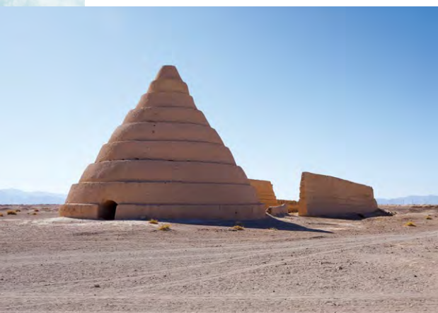
アバルクーの町の南にあるヤフチャール。ドームの奥に高さ4メートルの遮光壁が東西方向に2枚設けられている(イラン アバルクー、2025年)
