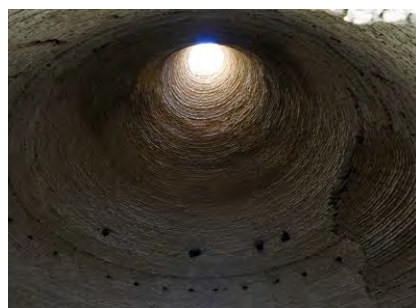
ヤフチャールのドーム頂上部の排気口(イラン アバルクー、2025年)
